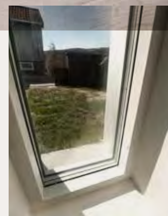
Vinduene står midt i vegg for å unngå dugg.
